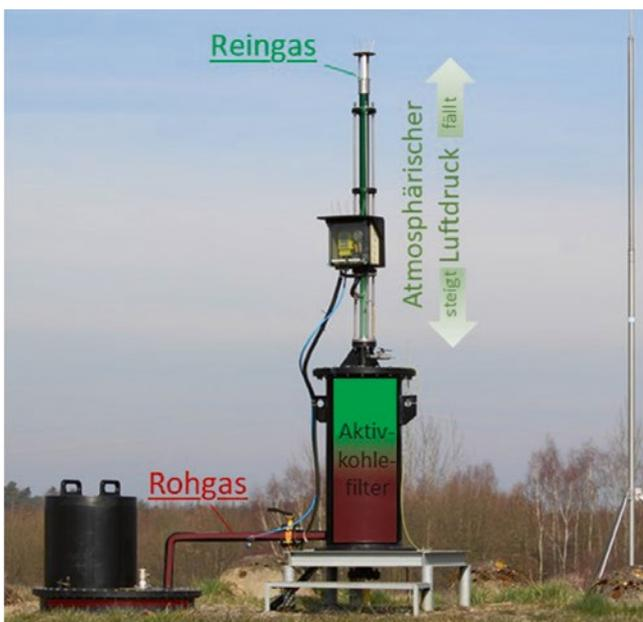
**Bild 6:** Aktivkohlefilter im Hochpunkt der GSM-Deponie
