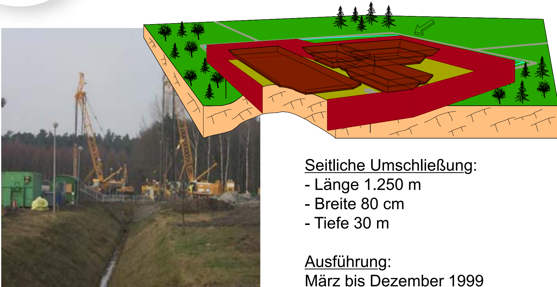
Schlitzwandfräsen im Einsatz
