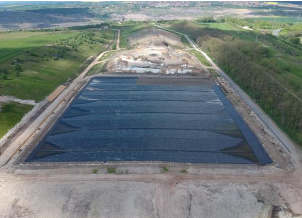
Deponieabschnitt 3 (in Betrieb)
